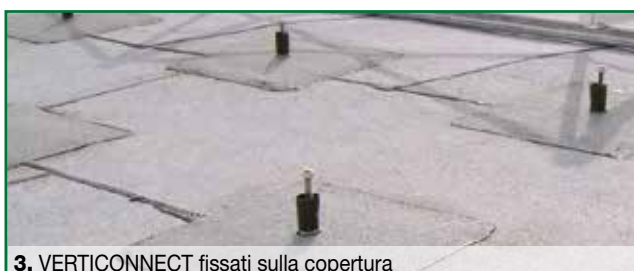
3. VERTICONNECT fissati sulla copertura
