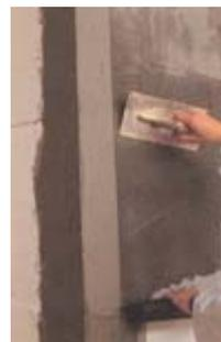
Sulla rasatura fresca, applicare la RETE sovrapponendo i teli di almeno 5 cm. Allettarla completamente eliminando pieghe e rigonfiamenti.
