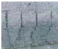
La carbonatazione procede più rapidamente quanto l'atmosfera contiene alte percentuali di anidride carbonica, nelle aree industrializzate e nel centro della città dove c'è un'alta percentuale di gas di scarico delle macchine. Le piogge acide accelerano l'alterazione del calcestruzzo e dei tondini d'acciaio la reazione chimica causa un aumento del volume attorno ai tondini di acciaio creando fessurazioni nel calcestruzzo.
